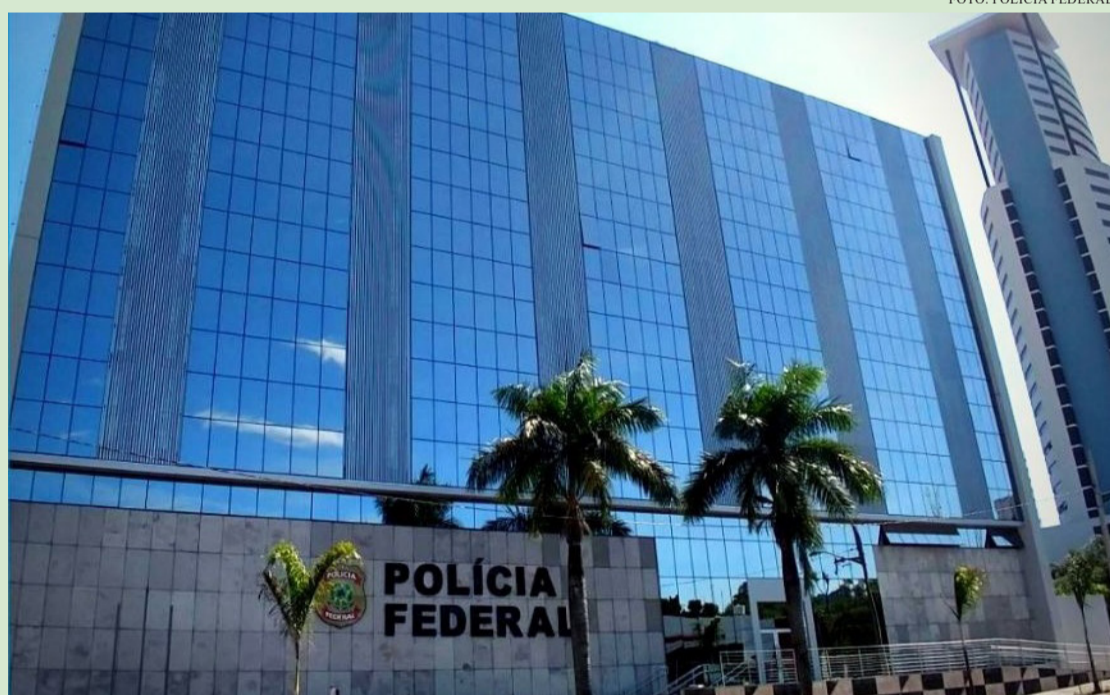
A SEDE DEFINITIVA DA POLÍCIA FEDERAL NO ESTADO FOI INAUGURADA EM 1996, NA AVENIDA HISTORIADOR RUBENS DE MENDONÇA (CONHECIDA COMO AVENIDA DO CPA), Nº 1.205, NO BAIRRO ARAÉS, EM CUIABÁ
